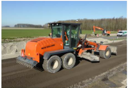
7. Profileren en verdichten
