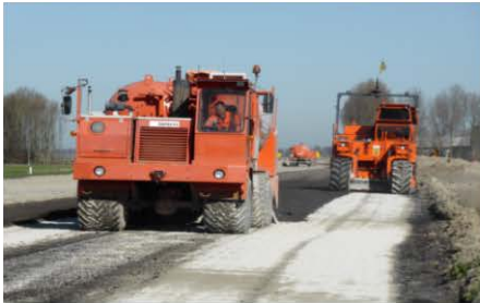
1. Uitrusten asfaltgranulaat in cunet
